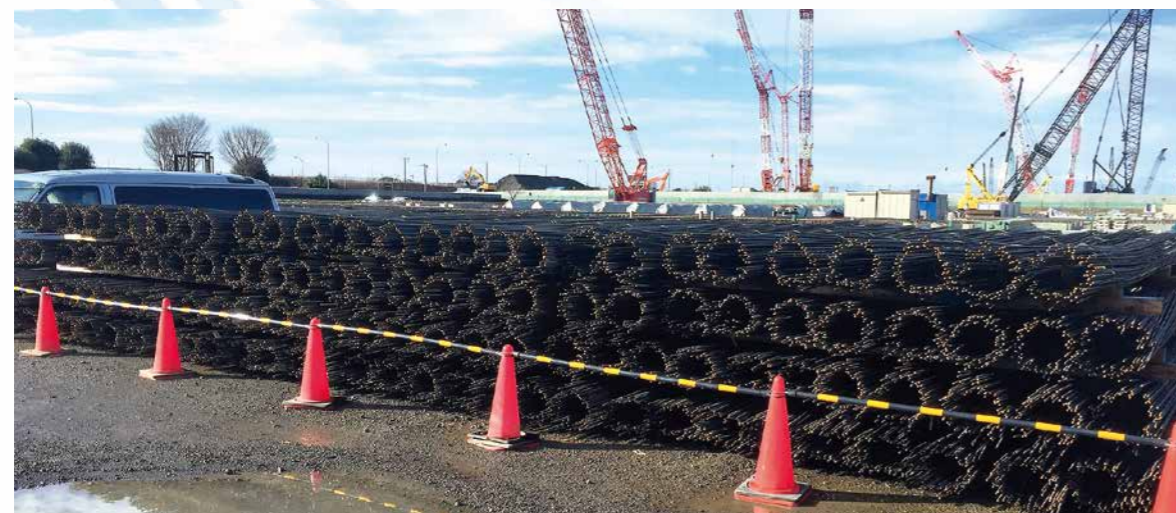
加工したロールをストックするためのヤードが必要です
