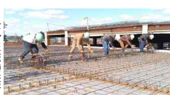
ロールマット工法の施工状況
